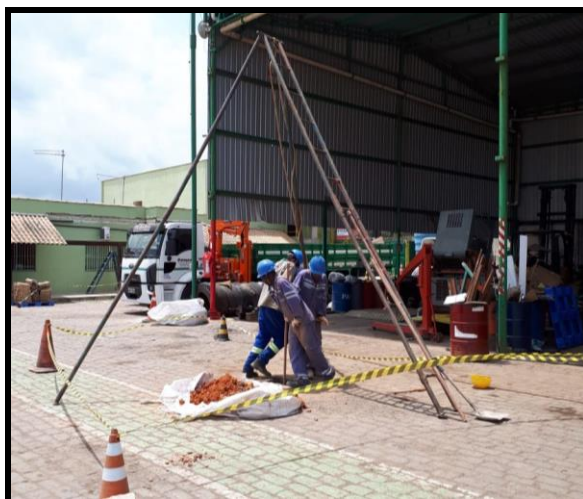
Foto 4: Início da sondagem da SD-3
