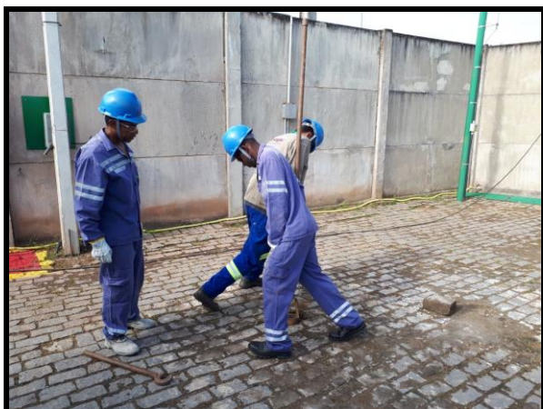
Foto 1: Início da sondagem da SD-1
