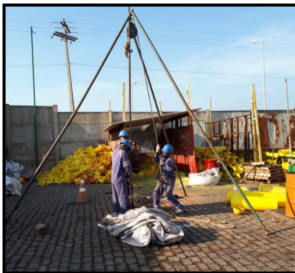
Foto 2: Início da sondagem da SD-2
