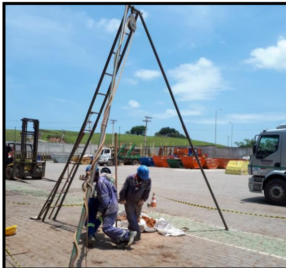
Foto 8: Início da sondagem da SD-5
